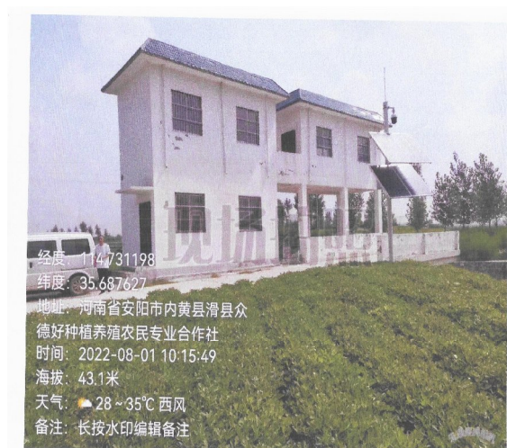
图 1 硝河小后河闸（梁庄镇）
