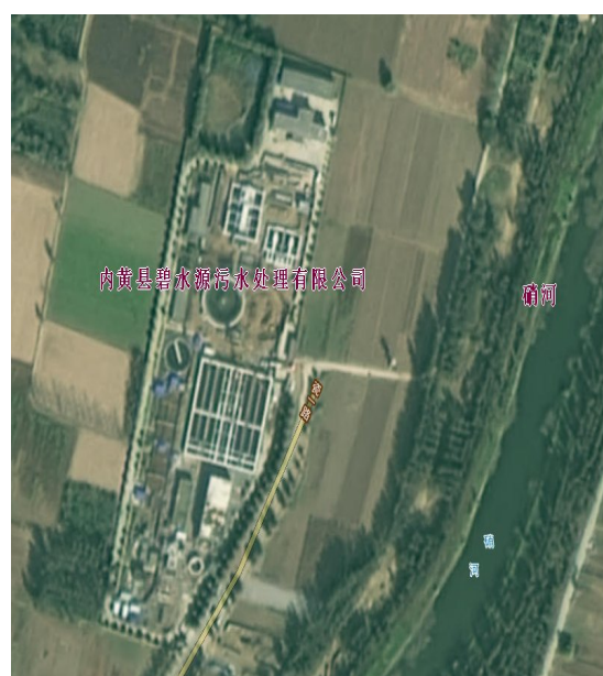
图 4 内黄县碧水源污水处理有限公司
