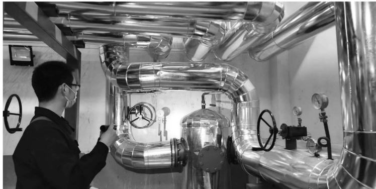
供暖管网检修现场
