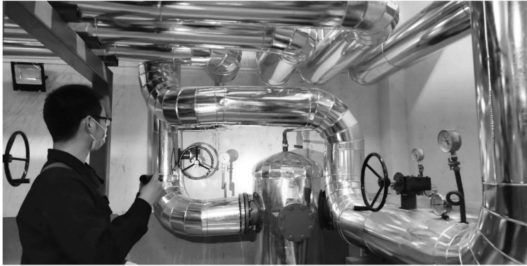
供暖管网检修现场
